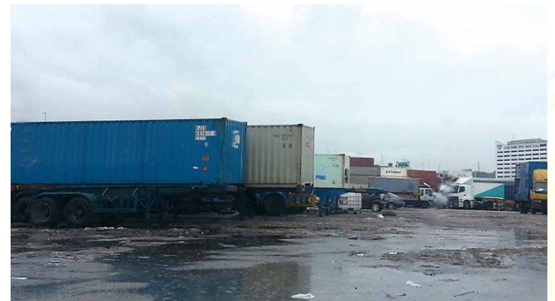
圖 4-2 位於葵涌的一個貨物中轉場，地面坑窪不平，下雨天積水處處
