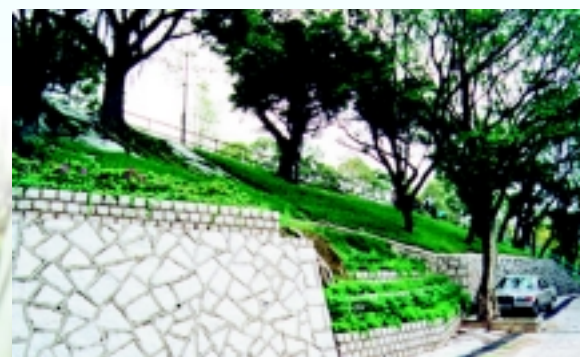
斜坡植有喬木和灌木。
