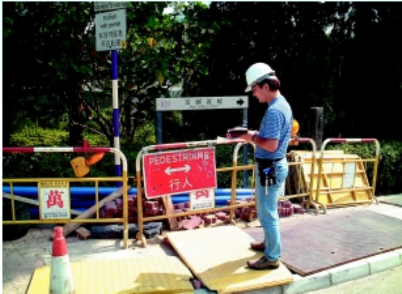
安環處職員定期檢查建築工地的管理、安全和環保措施。
