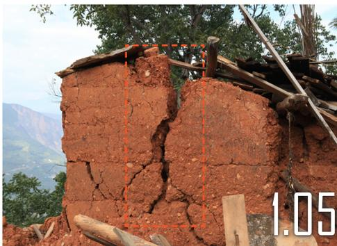
五、墙身整体性差，裂缝展开贯通导致大块墙体掉落 (图 1.05)
