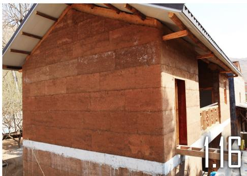
房间尺寸、开窗大小可参考砖混结构(图 1.17), 传统生土民居开间不大、布局受限制、日照不足、通风不畅的缺点得到彻底解决。夯土墙顶设钢筋混凝土压顶梁, 加强对挑梁的约束, 避免挑梁在地震作用下横向摆动破坏夯土墙体。
