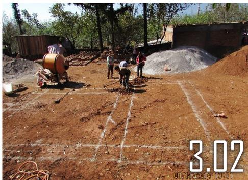
地基施工前测量放线 (图 3.02)
