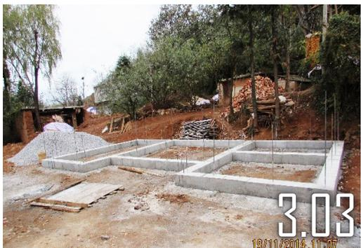
钢筋混凝土基础浇筑 (图 3.03)
