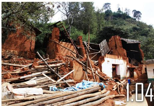
四、屋面木檩搁置在夯土墙顶部，缺乏与夯土墙的连接，地震时易发生屋面垮塌 (图 1.04)
