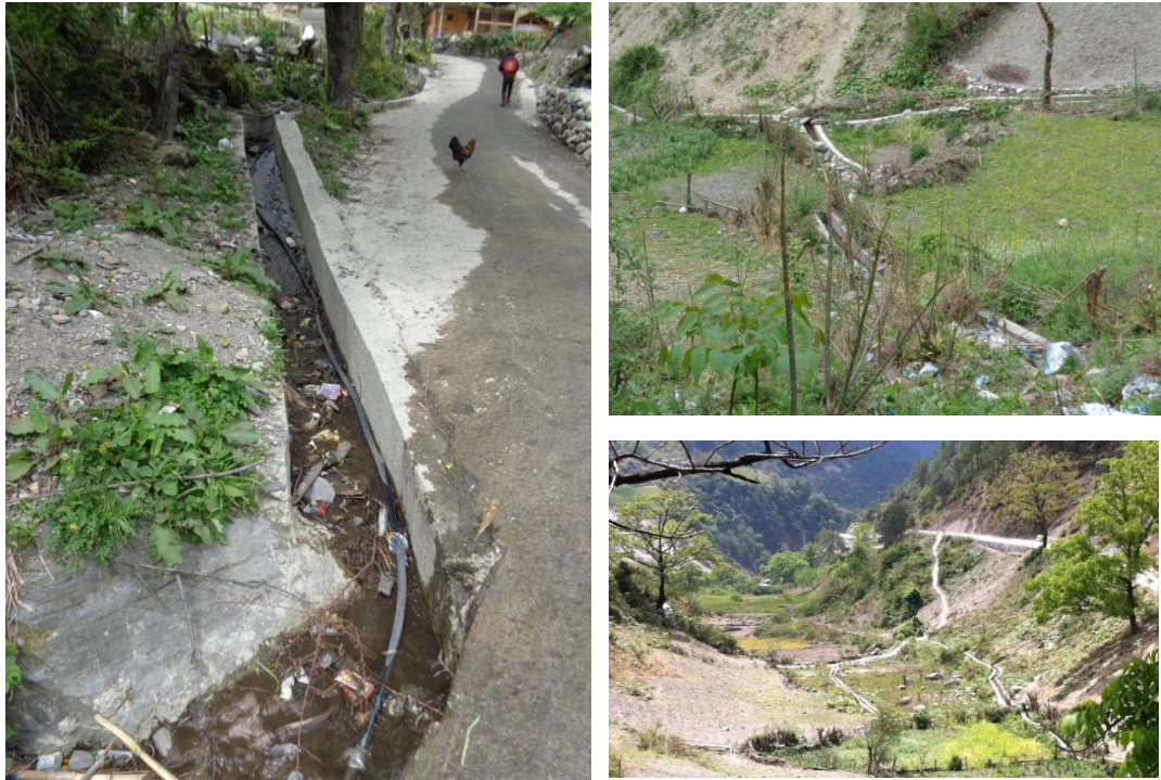
图 3-7 初岗组兼具灌溉功能的主排水渠
